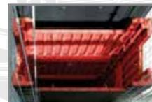
Sistema de encofrado con esquinas articuladas
